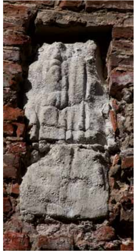
Abb. 14a–c Burg in Wenden, Konsolen aus Kunststein; links: ‚Landmeistergemach‘; Mitte: Südremter, nordöstliche Eckkonsole; rechts: Südremter, flache Konsole an der Nordwand, 2021
