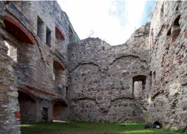
Abb. 4 Burg in Wenden, Ostflügel, Innenansicht der Ruine, ehemaliger großer Remter, 2016
