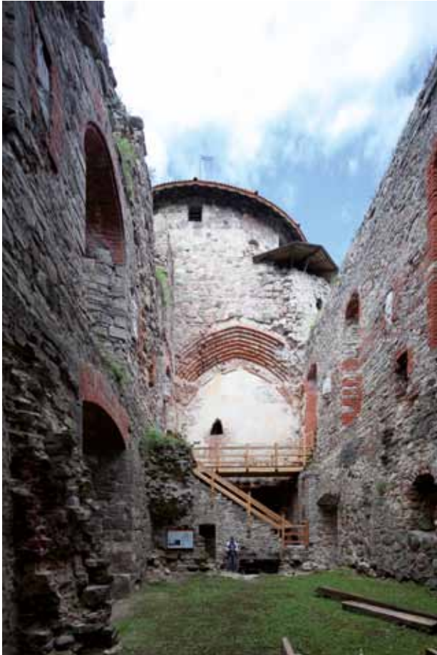
Abb. 17 Burg in Wenden, Südremter aktueller Zustand, Blick nach Westen, 2016
