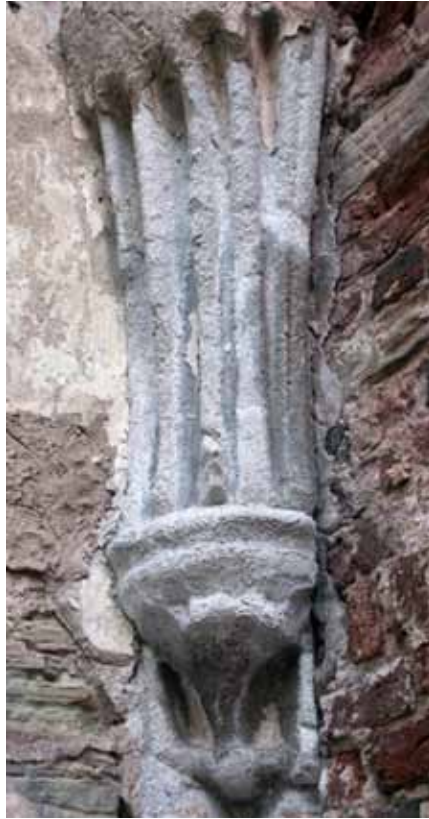
Abb. 14a–c Burg in Wenden, Konsolen aus Kunststein; links: ‚Landmeistergemach‘; Mitte: Südremter, nordöstliche Eckkonsole; rechts: Südremter, flache Konsole an der Nordwand, 2021
