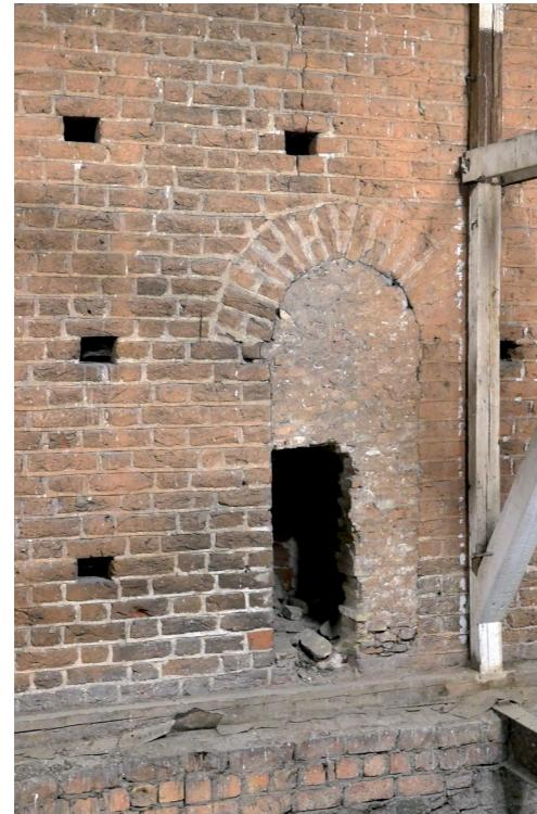
Abb. 20 Vermauerte Öffnung in der Obergadenzone des Chors der Petrikerche, Ansicht von der Dachseite, 2022
