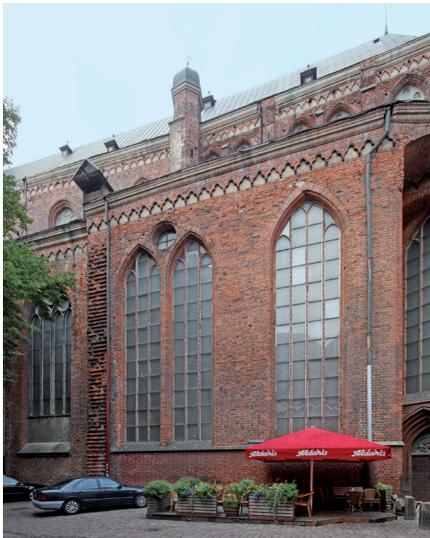
Abb. 15 Ansicht der beiden westlichen Chorkapellen auf der Südseite. An der linken Kante sind die Verzahnungsspuren zum Anschluss des ursprünglich geplanten Querhauses zu erkennen.
